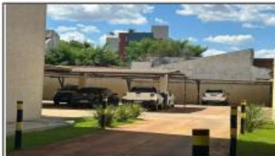
Garagens terrea fundos cobertas
