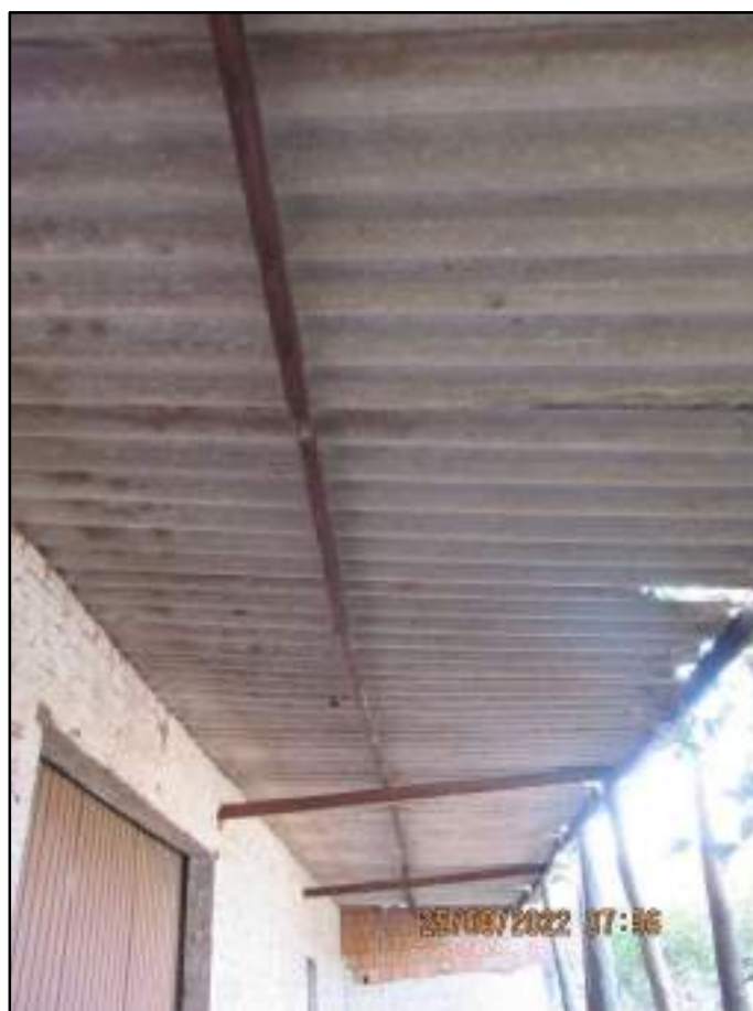
Imagem 12: Cobertura com telha de fibrocimento.
