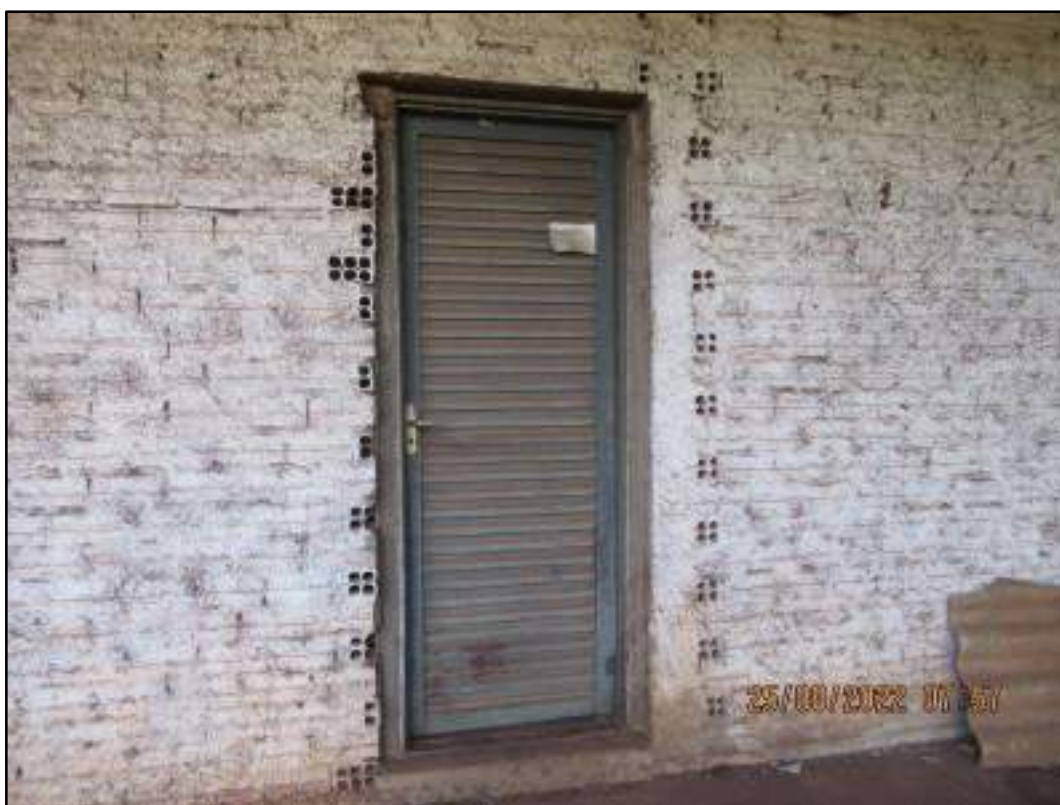
Imagem 14: Porta metálica da entrada da edificação.
