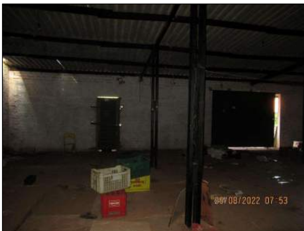
Imagem 18: Vista do interior da edificação.
