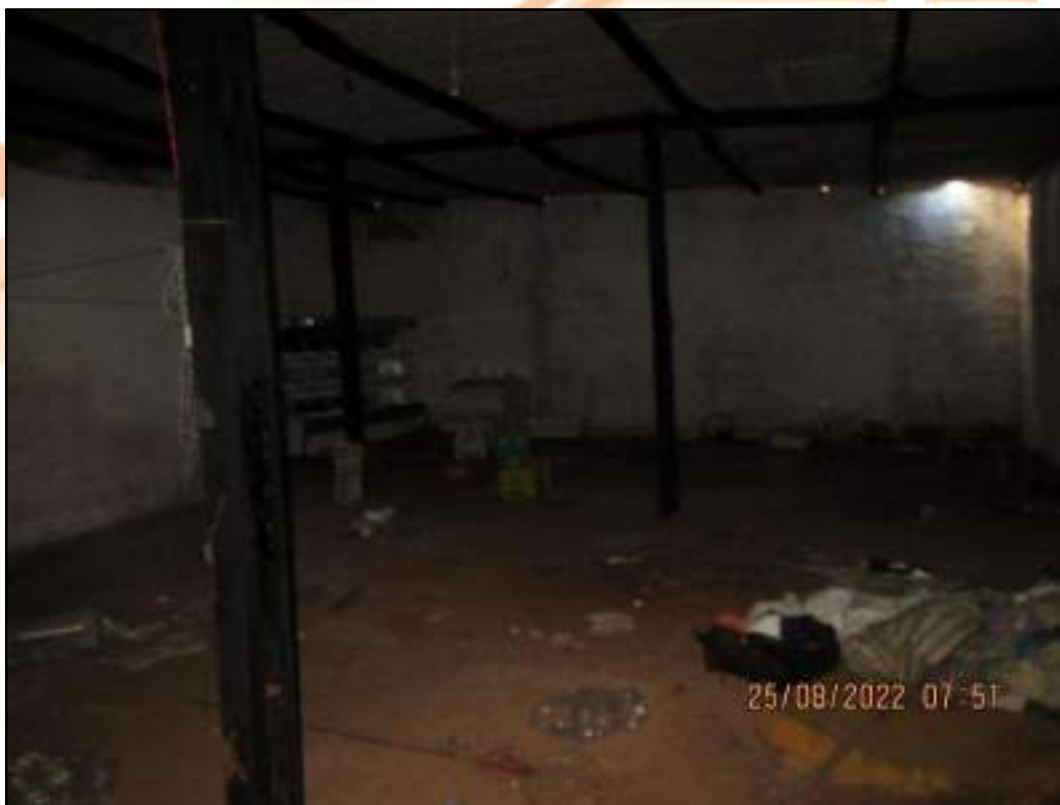
Imagem 15: Vista do interior da edificação.
