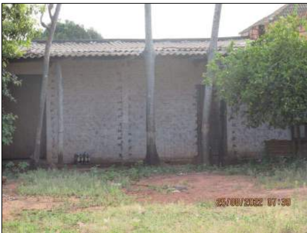
Imagem 10: Vista da fachada da edificação.
