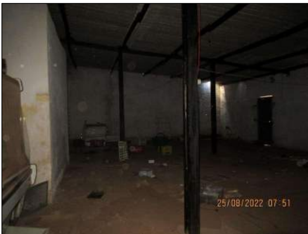
Imagem 16: Vista do interior da edificação.
