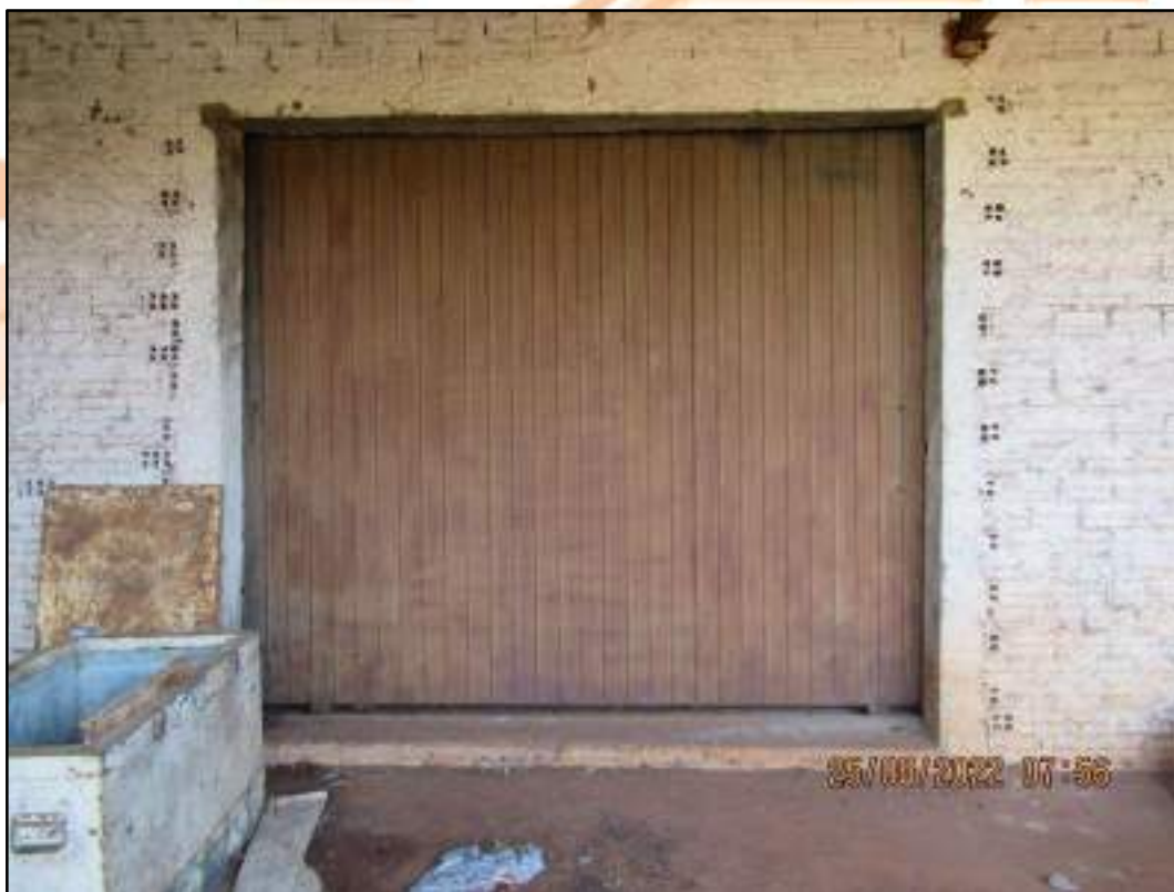
Imagem 13: Portão metálico da entrada da edificação.
